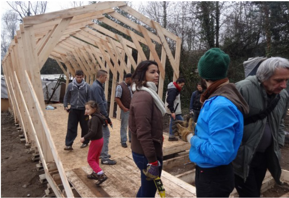
Construction de l'Ambassade du PEROU dans le bidonville de Ris-Orangis © Chloé Bodart
